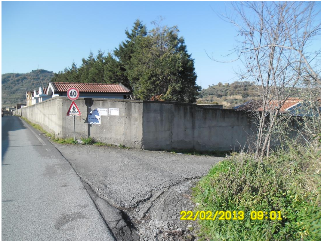
vista muro recinzione cimitero esistente da S.P. 65 ove è previsto l'ampliamento cimiteriale
