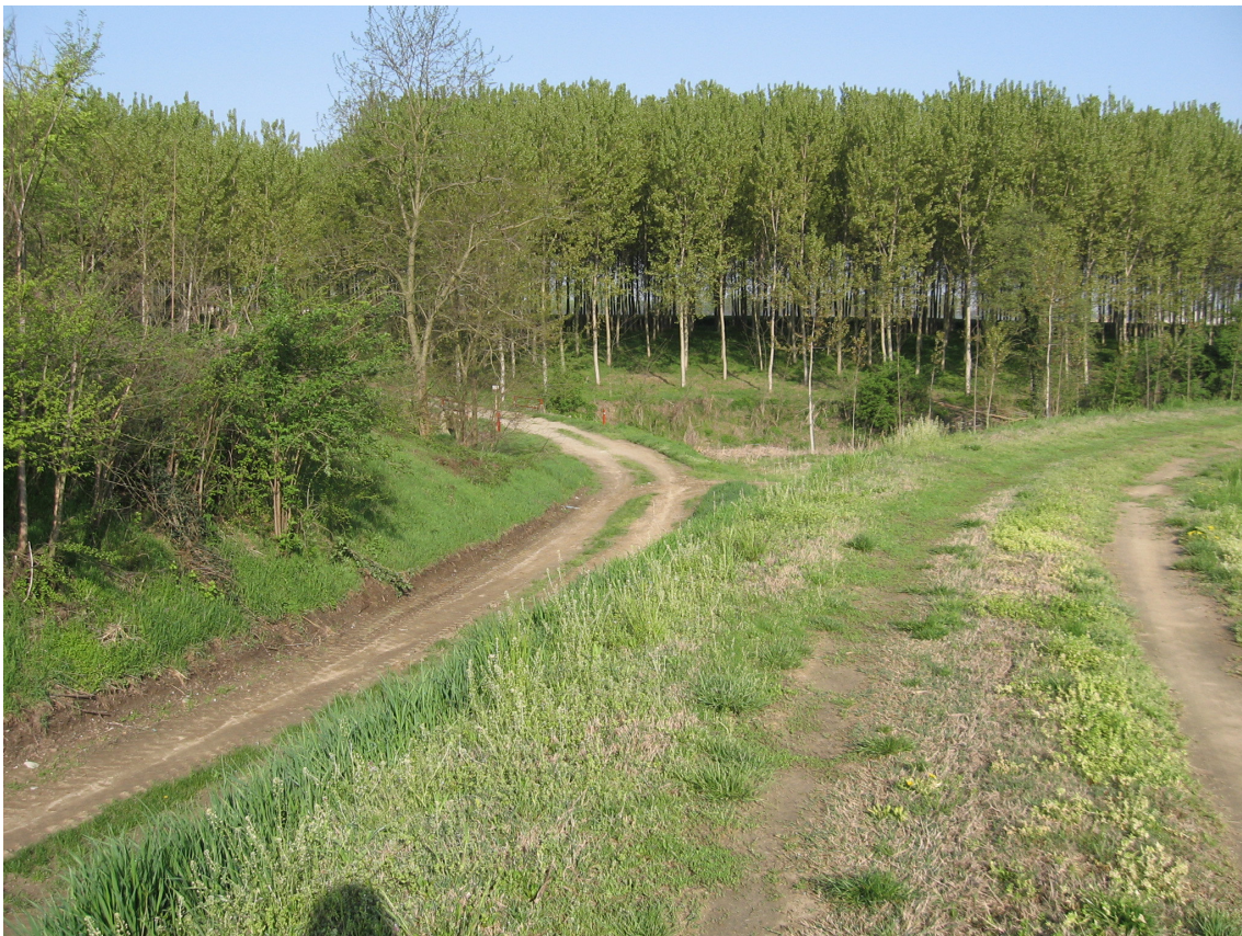
FOTO 7 - Scaricatore Marocco-Roggiolo. Veduta generale.
