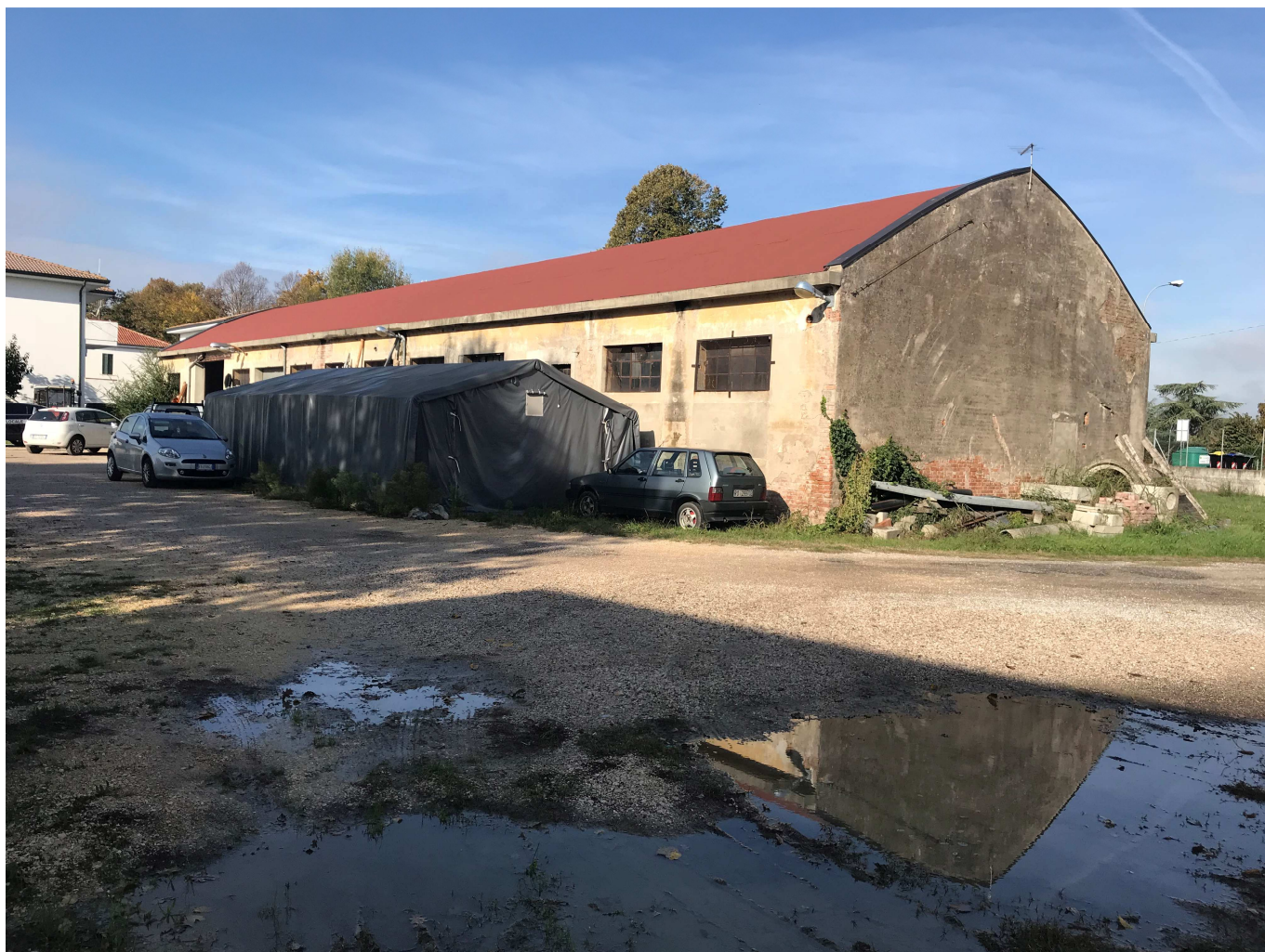
VEDUTA DELLA PARTE POSTERIORE DELL'AREA E DEL FABBRICATO - LATO SUD
